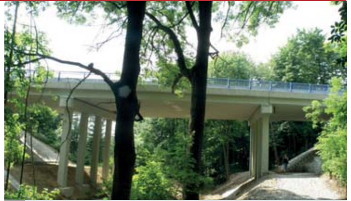
2 The bridge on the road I/19 - Nové Město na Moravě
