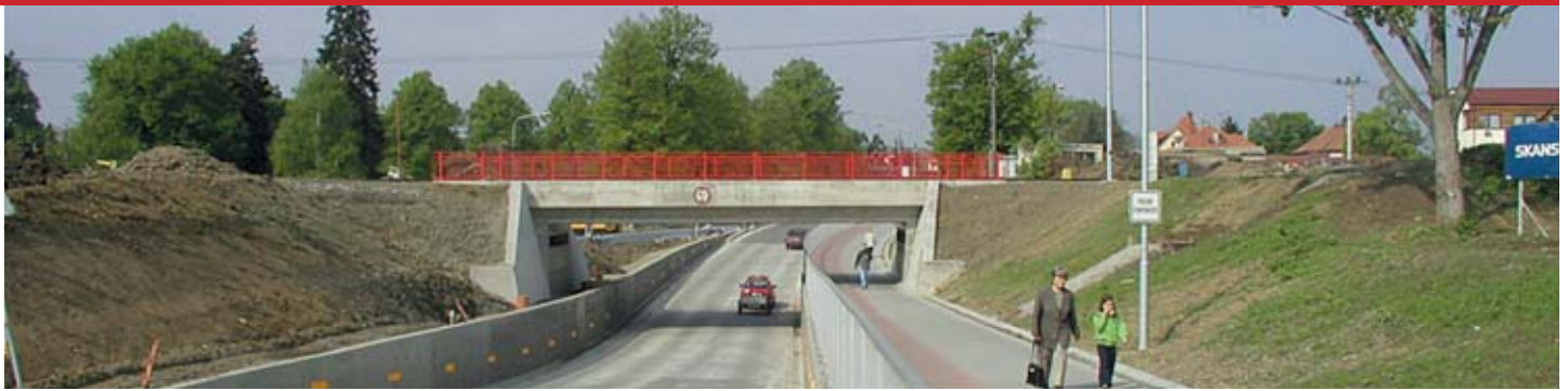
1 Bridge in Uherské Hradiště on the railway line Kunovice-Staré Město
