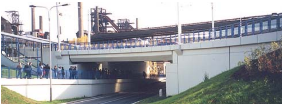
3 Tram Bridge on Street Místecká in Ostrava
